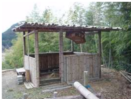
休憩小屋の修復（竹の再利用）
