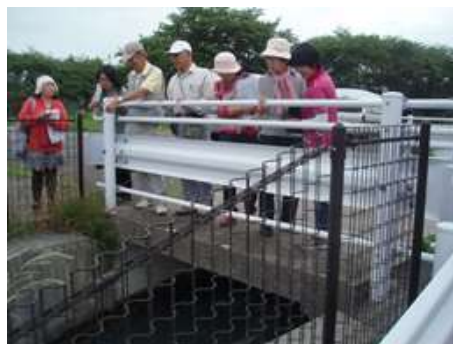
小水力発電有力用水路
