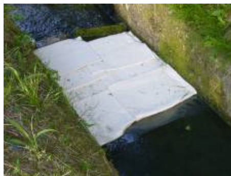
油流出事故での吸着マットの敷設
