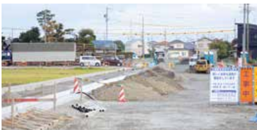
工事が進む市道東町御請線
