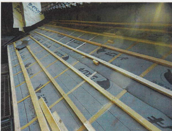
ルーフィングの施工
