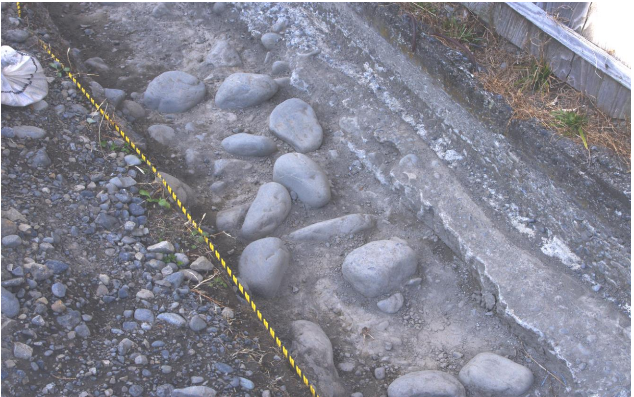
仲間の宿横のトレンチ (廂から4間の位置に根石に使用された河原石が散乱していた)
