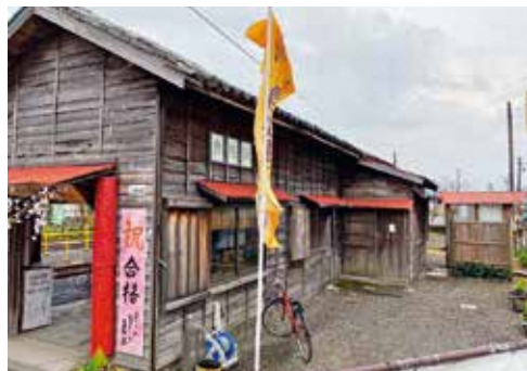
改築が要望される合格駅トイレ舎
