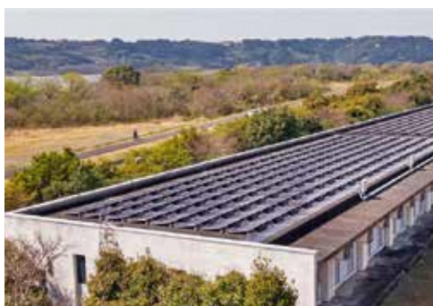
下水処理場の太陽光発電
