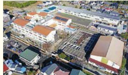
改築中の第四小学校
