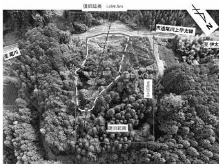
期待される尾川上伊太線の復旧工事
