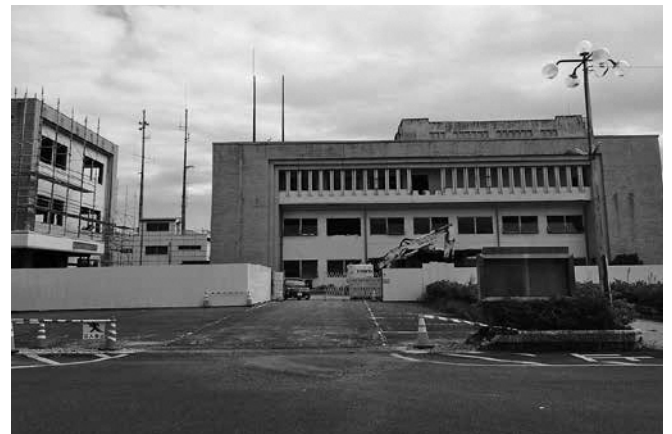
解体される旧金谷庁舎
