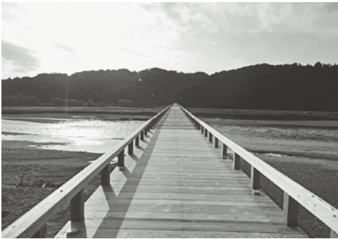
蓬萊橋左岸側から右岸側を望む
