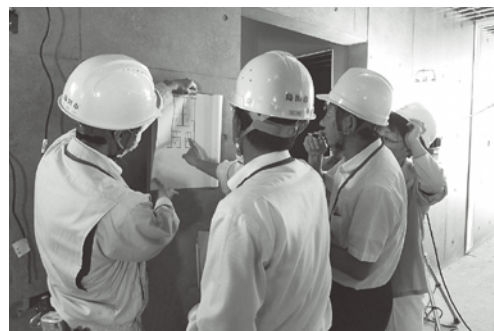
総務生活常任委員による、建設中の新庁舎における給排水衛生設備の現地確認の様子
