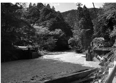
台風の復旧工事に掛かる市井平橋
