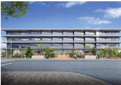
来夏、竣工予定の市役所新庁舎
