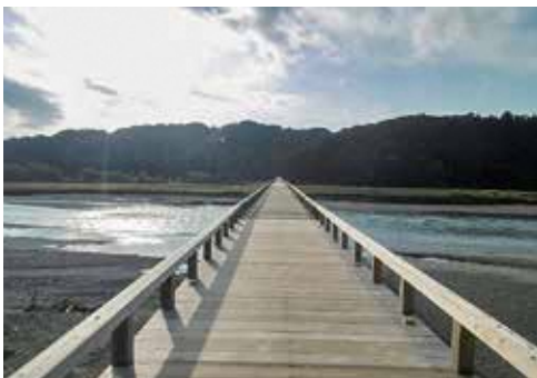
蓬莱橋左岸側から右岸側を望む
