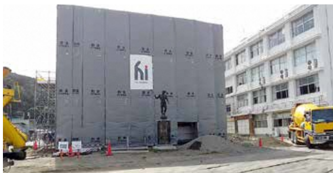
金谷高等学校（改築工事の様子）
