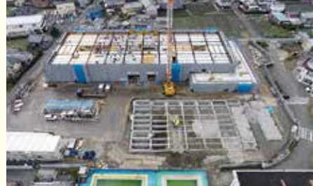
建設中の島田第一小学校
