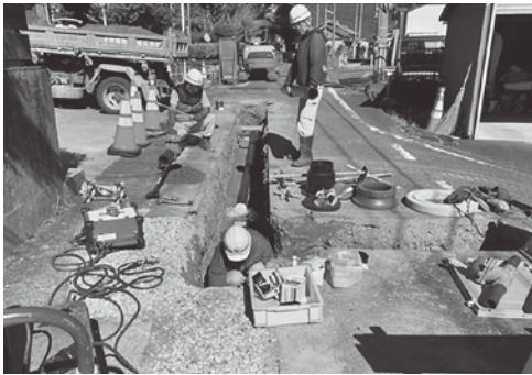
暑い中の配水管（耐震管）布設替え現場
