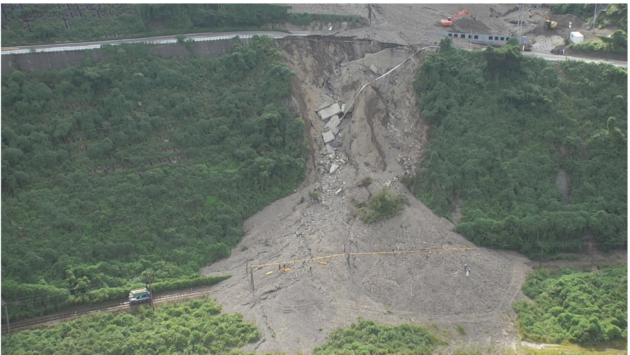
国道473号線 島田市福用地内（旧福用産業付近） 9月26日 14時頃
