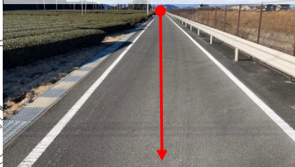
②【認定】(終点) 473 バイパス側道 1 号線
