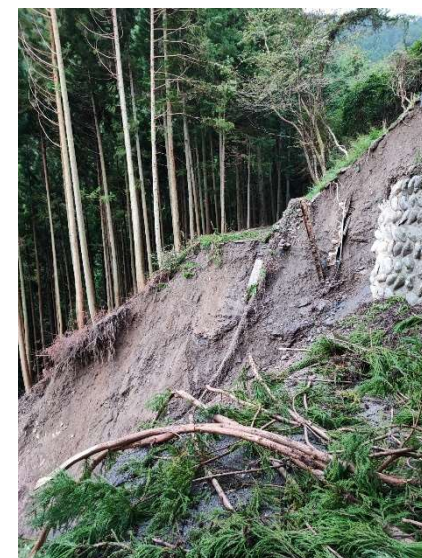
(災害により崩落した林道)
