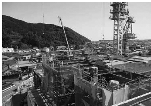
建設中の新市民病院 (19年9月下旬)
