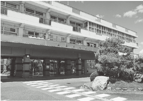
改築が待たれる現市役所庁舎
