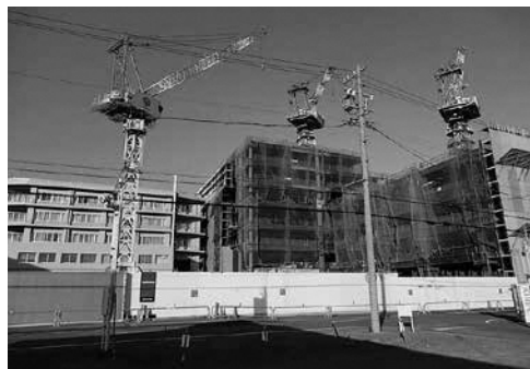
建設中の新病院
