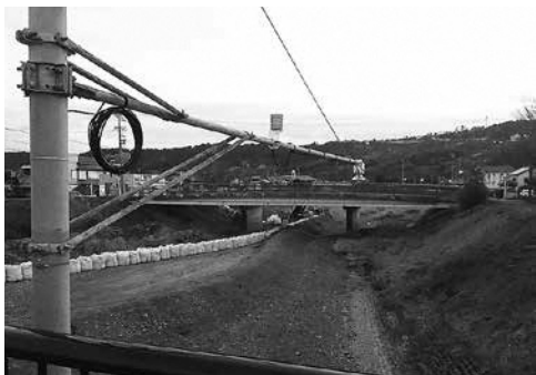
県で設置された水位測量計！
