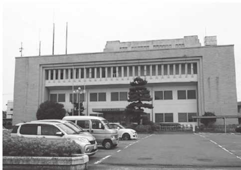
解体が延期された旧金谷庁舎
