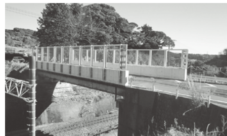
橋りょう長寿命化修繕
