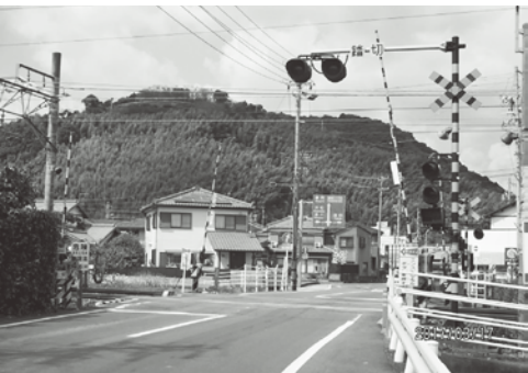
東海道本線栃山踏切の拡幅決定
