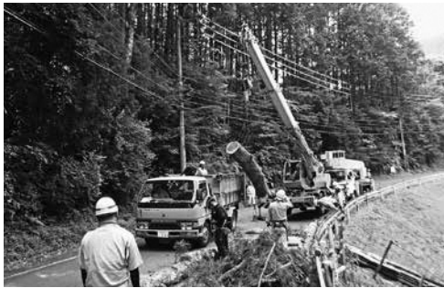
停電対応のための事前伐採の様子
