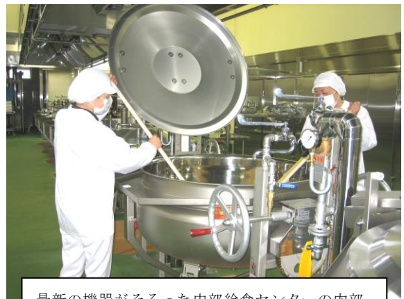
最新の機器がそろった中部給食センターの内部
