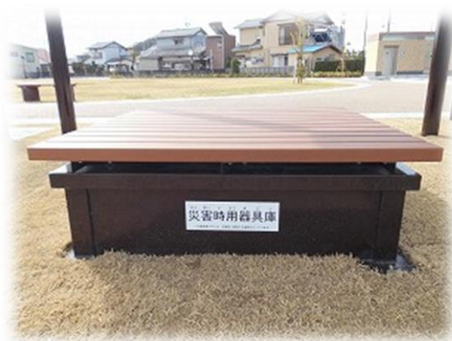
■東屋と災害時用器具庫付き縁台
