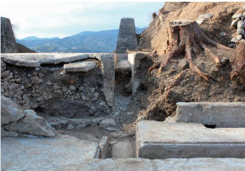
C 発電室と電源室の接合部破壊状態
