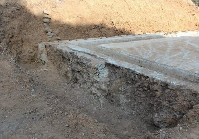
A 発電室西側の基礎破壊状態（西南から）
