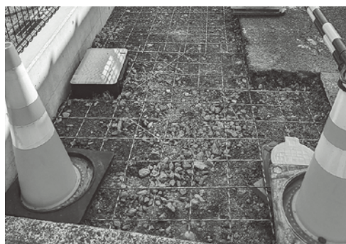
地下水利用から上水道併用利用への工事現場
