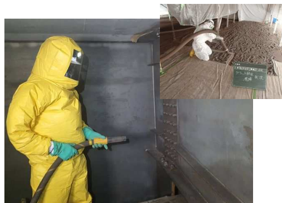
図 4.1.4 新技術によるケレン事例
