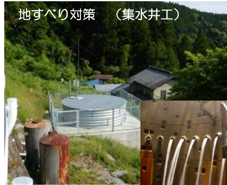
集水ボーリング工 （集水井内部）
