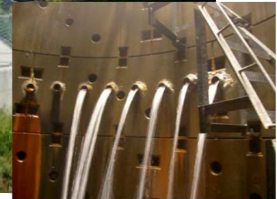
集水ボーリング工 （集水井内部）
