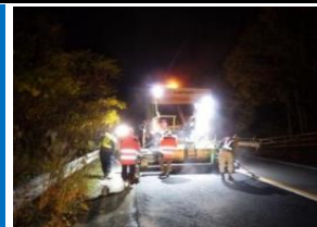
（舗装修繕工事）
