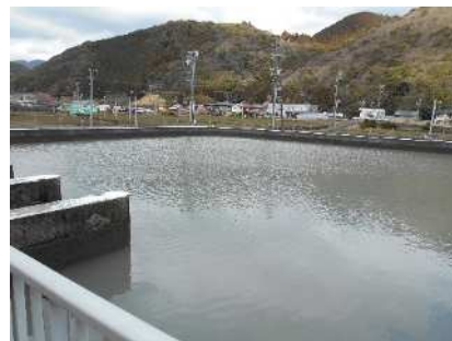
【牧之原揚水機場】
