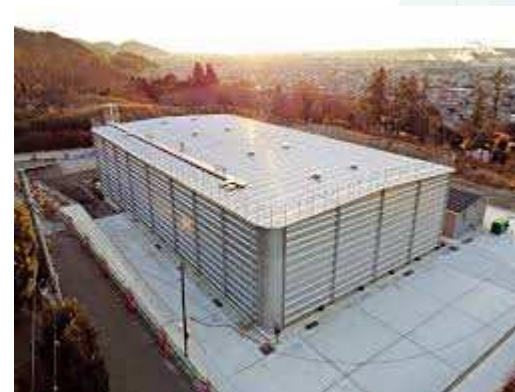
写真 天神原配水池(有効容量3,900m3)
