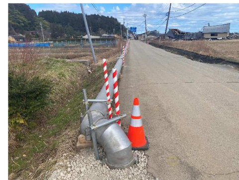
珠洲市 送水管復旧
