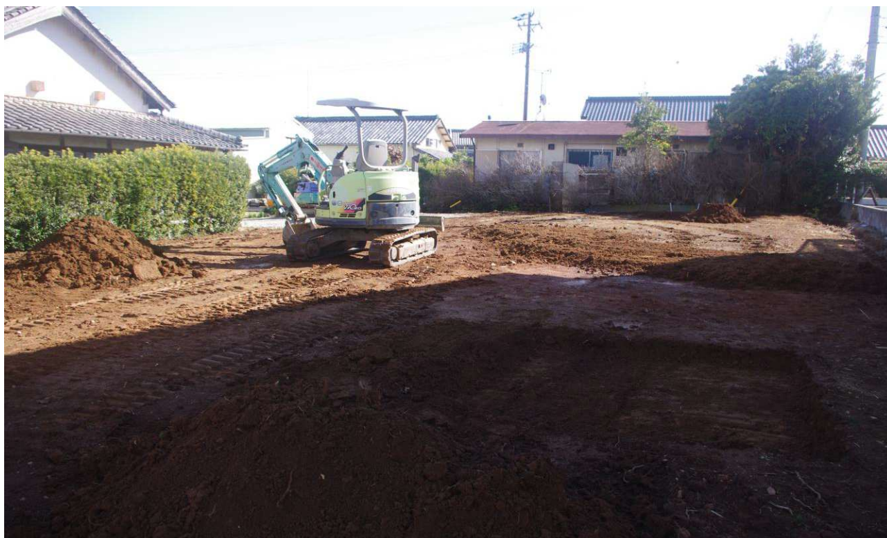
医王寺南遺跡確認調査風景
