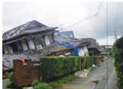
熊本地震で倒壊した家屋
