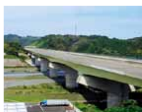
建設中の新大井川橋
