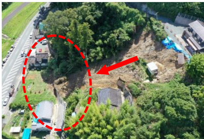
がけ崩れ発生全景 (R6.8.25)
