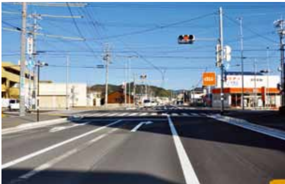
幅が広がって一直線に伸びる大津通り
