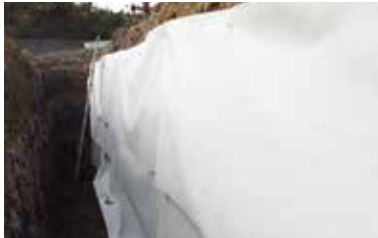
ゼオライトシートで処理灰を覆う工事を実施(H27.12)
