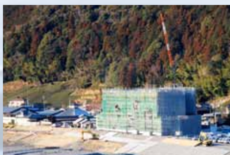
建設が進む川根温泉ホテル(左が川根温泉)
