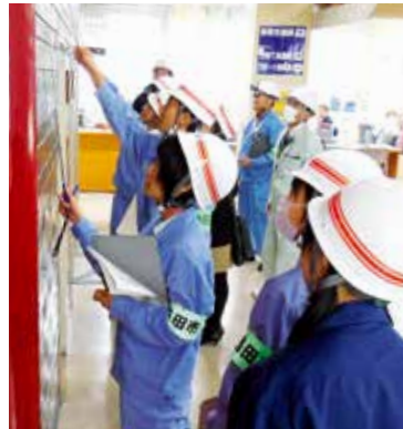
市役所庁舎のタイルの浮きを調査
