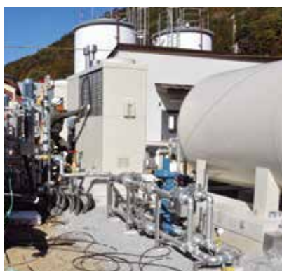
工事が進められている発電施設
