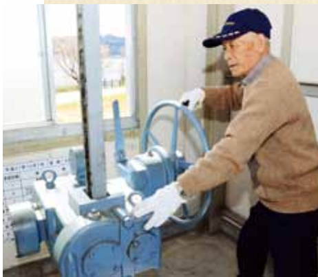
手動の水門を調節して 大井川に排水する
