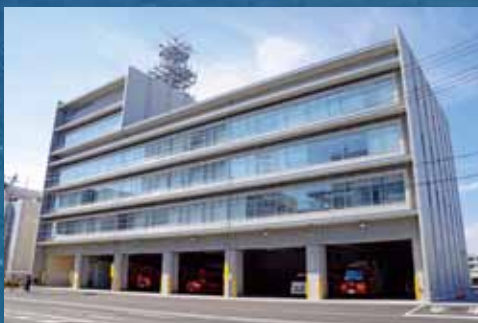
消防指令センターのある静岡市消防局
