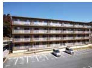
大草 D 棟市営住宅
