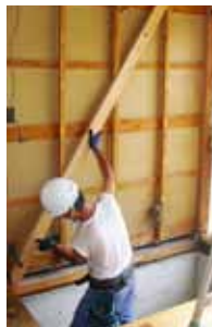
耐震補強工事
