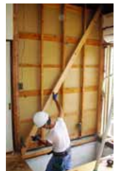
耐震補強工事
