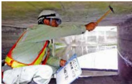
橋の打音調査
