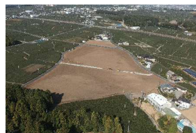
切山地区基盤整備着工後の様子
