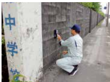
北中のブロック塀を点検する職員
