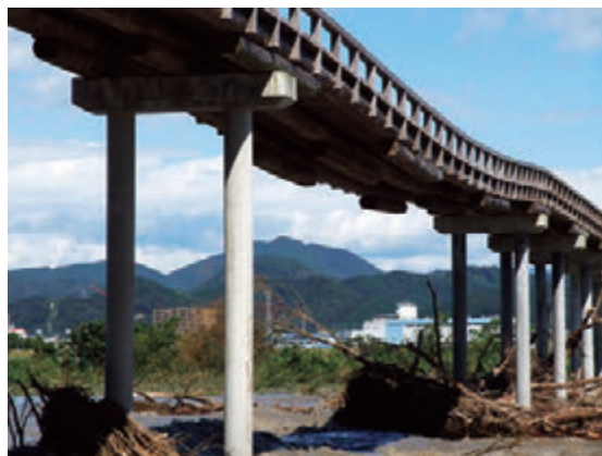
▲平成23年9月の台風で蓬莱橋の橋脚が流出
