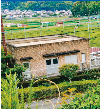
大規模団地共同浄化槽は、施設老朽化と住民高齢化により、民間管理の限界到来
