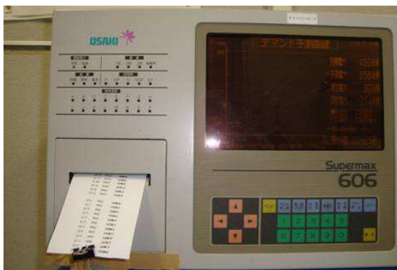
デマンド・コントローラーで電気使用量を管理
