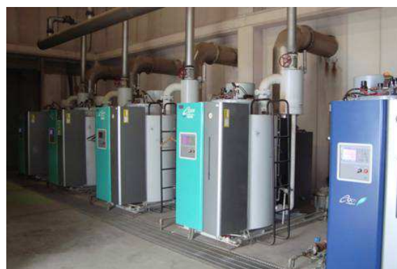
ボイラー室の5基の貫流ボイラー（重油焚き）
